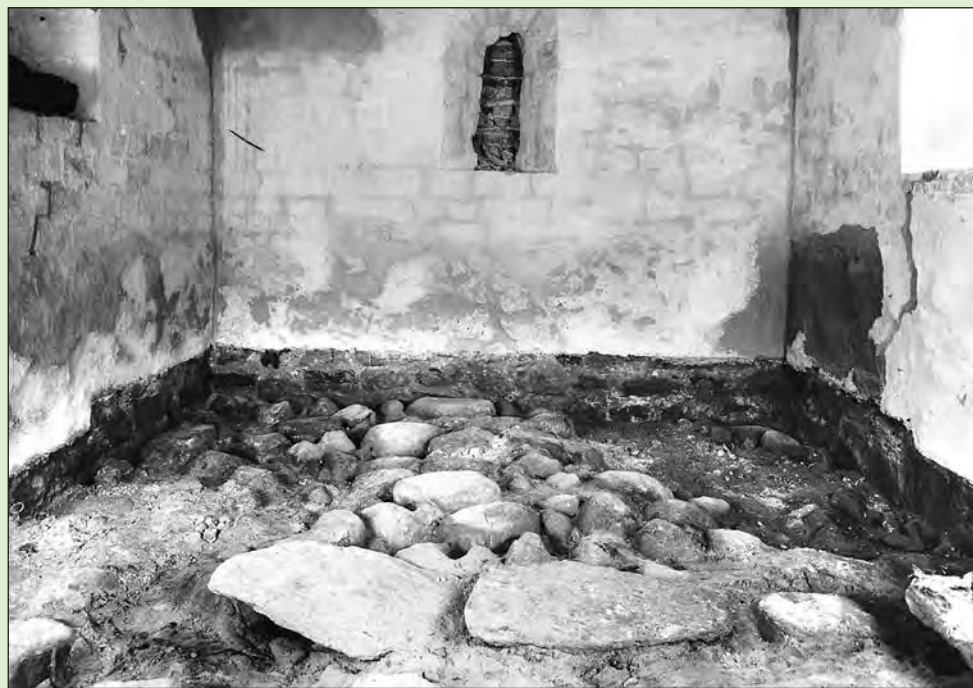
Udgravningen af koret fra 1960.
